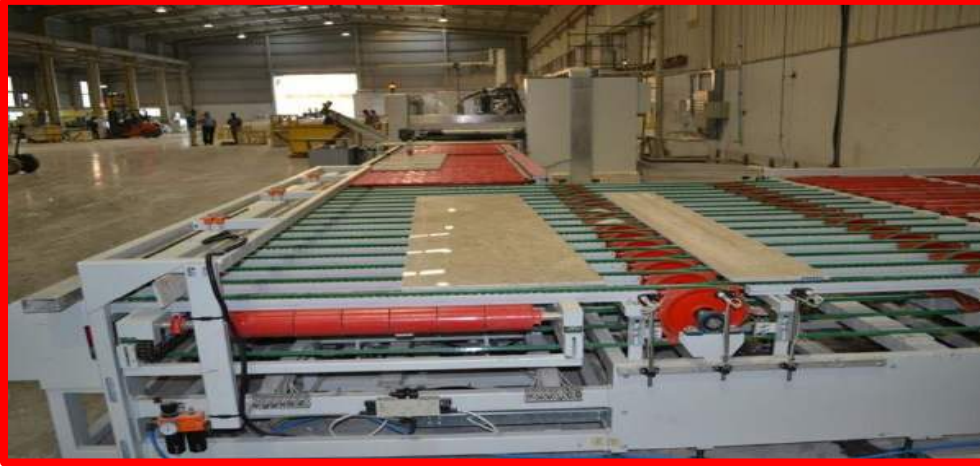
مجمع الرخام والجرانيت بجفافة (سيناء)
